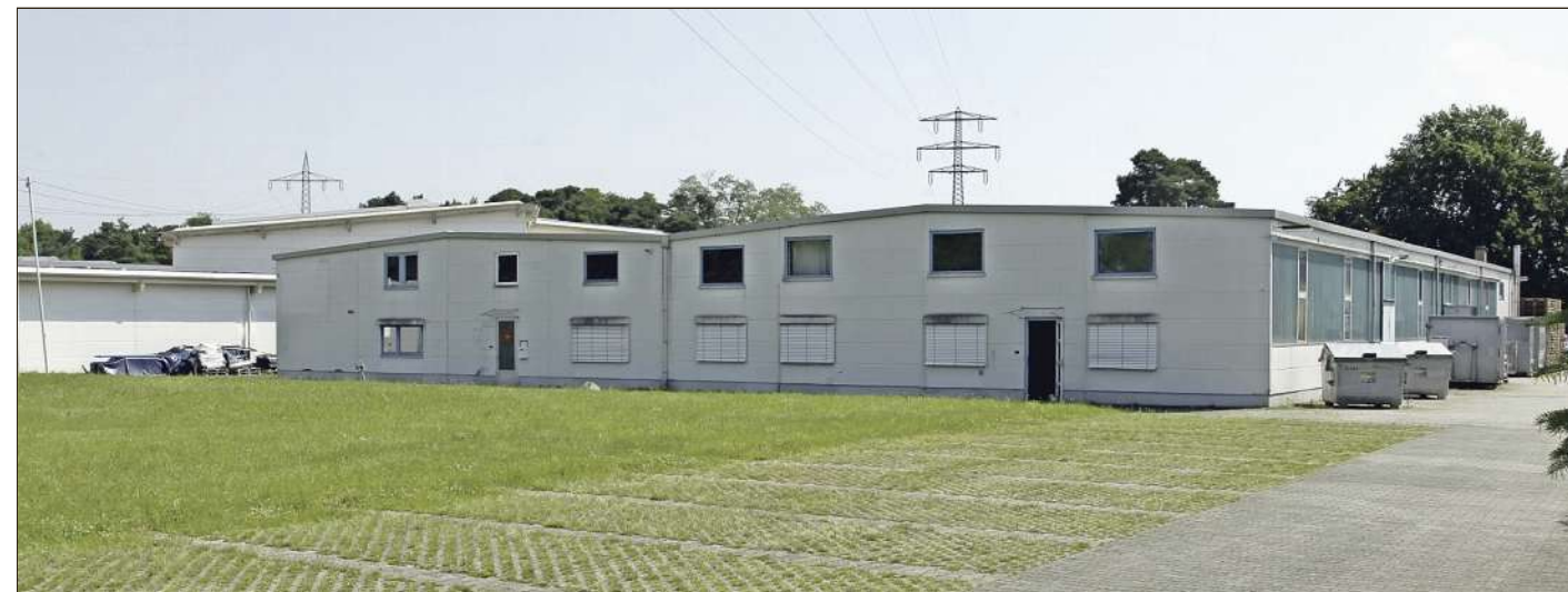
Die Firma Claus will die Lagerkapazität erhöhen und die innerbetriebliche Logistik verbessern.
